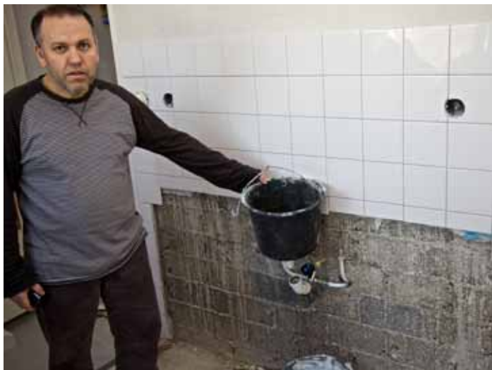
De heer Cherief toont zijn keuken in aanbouw
